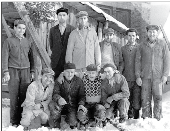
S pracovníkmi pri stavbe kultúrneho domu
