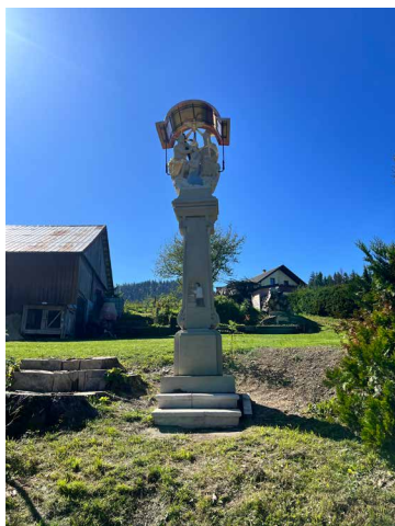
Obnova Svätej trojice v časti obce Podešťanská pri č. d. 873 – zrekonštruovaný kamenný stĺp, na ktorom je osadená sv. trojica.
